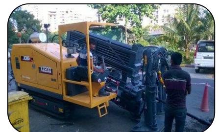
HDD & OFC CABLE LAYING
